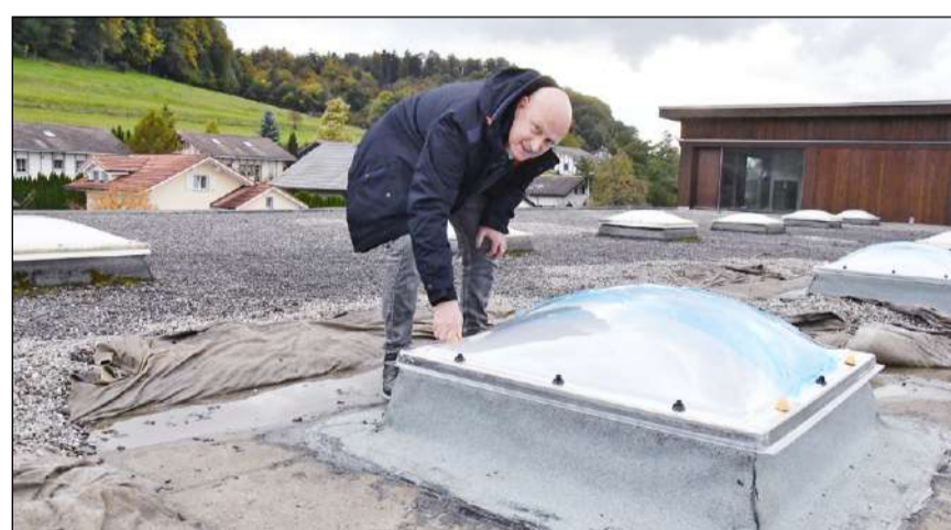
Gemeinderat Jack Roos begutachtet die neue Dachkappe. Foto: hhs
